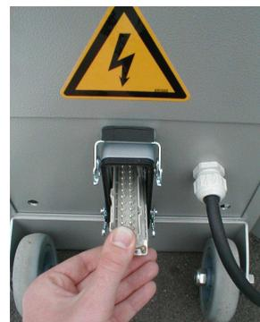
**3 – Une fois le connecteur mis en place sur son support visser les quatre vis aux angles du connecteur**
