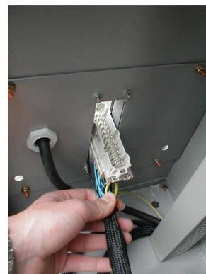
**2 – Reprendre le connecteur à l'extérieur de l'armoire puis le sortir afin de bien pouvoir l'appliquer sur sont support.**
