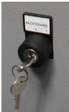
Position 0 : Normal (fonctionnement avec interrupteur de sécurité)
